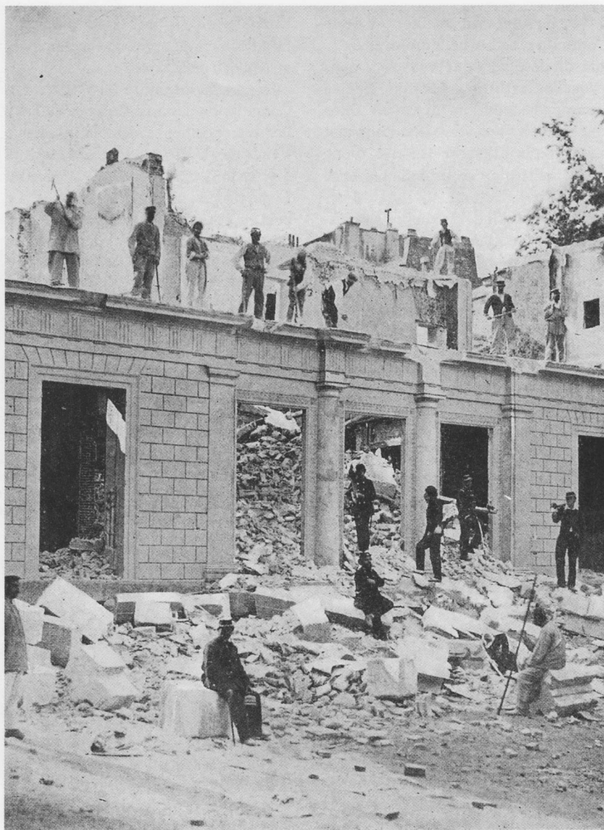
Démolition de la maison de Thiers. La Commune. A. Dayot 1901.
